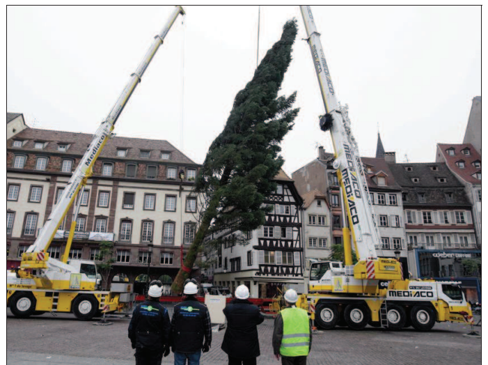
La mise en place du grand sapin de Noël, haut de 30,50 mètres et venu de La Bresse, dans les Vosges, hier matin sur la place Kléber à Strasbourg. Photo L'Alsace/Dominique Gutekunst
